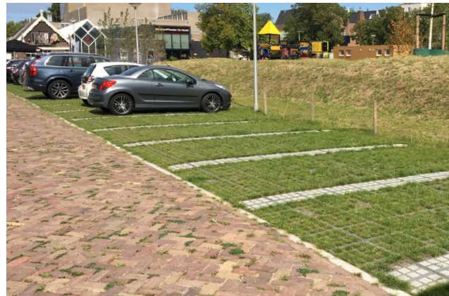
voorbeeld kleur- en materiaalverschil tussen rijbaan en parkeerstrook
